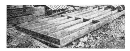
BILD 3. Versuchsstück eines Deckenpanels
