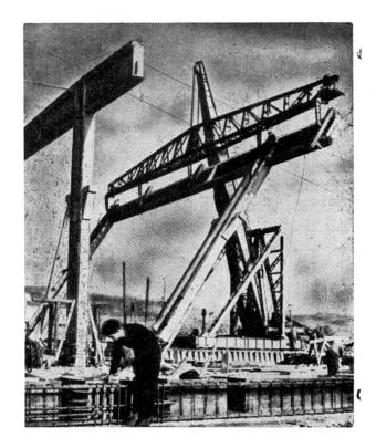
BILD 8. Montage des zweistieligen Rahmens
