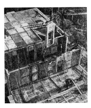
BILD 6. Montage von Panele
