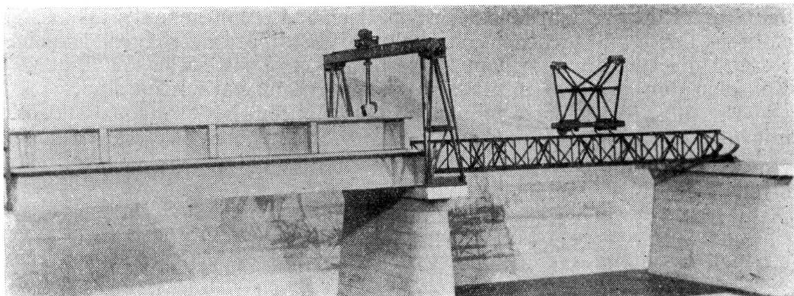
FIG. 3. Hilfsfachwerk und Montagekrane für eine Autobahnbrücke
