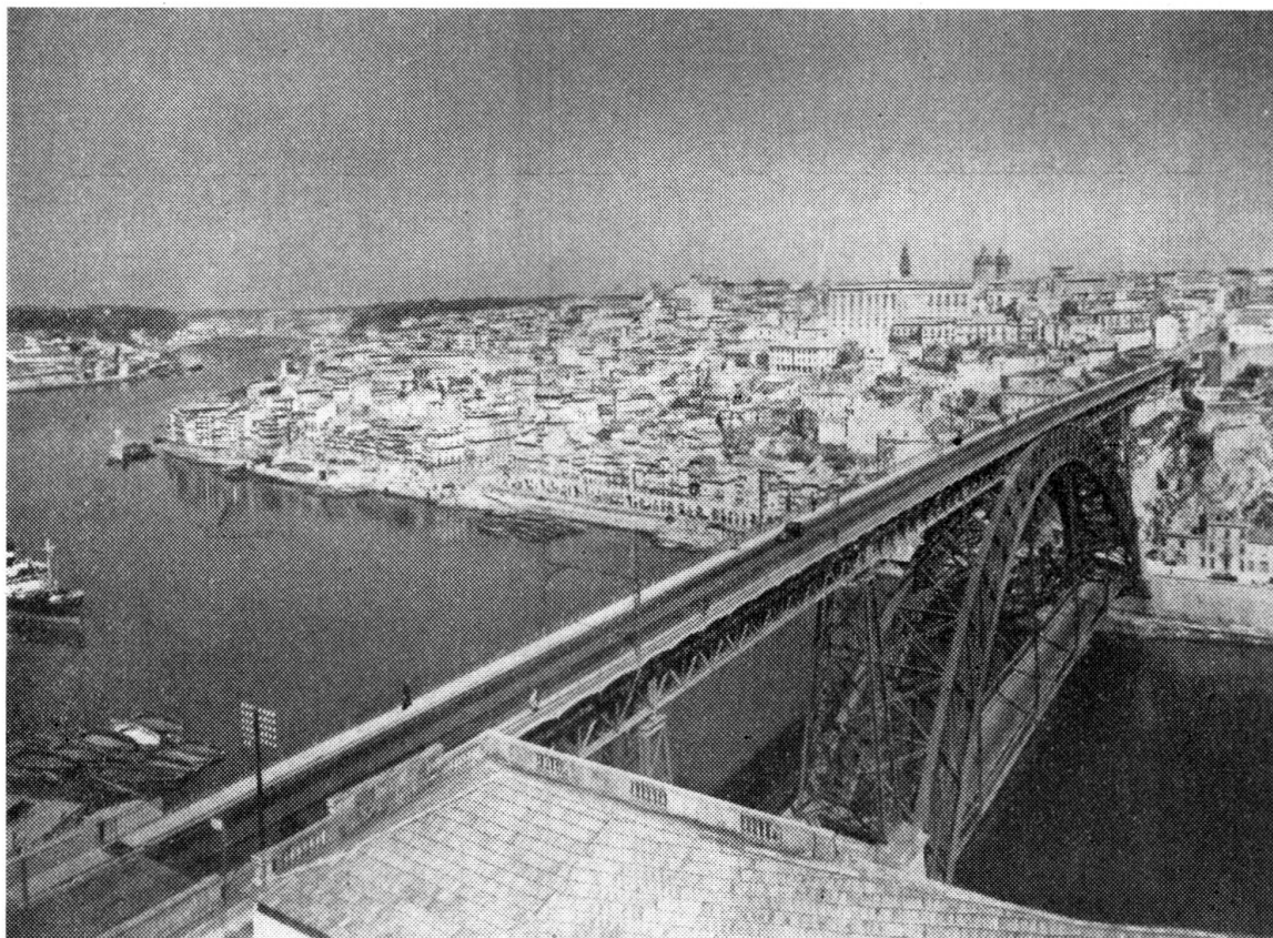
FIG. 17 — Ponte Luís I, sobre o Douro
