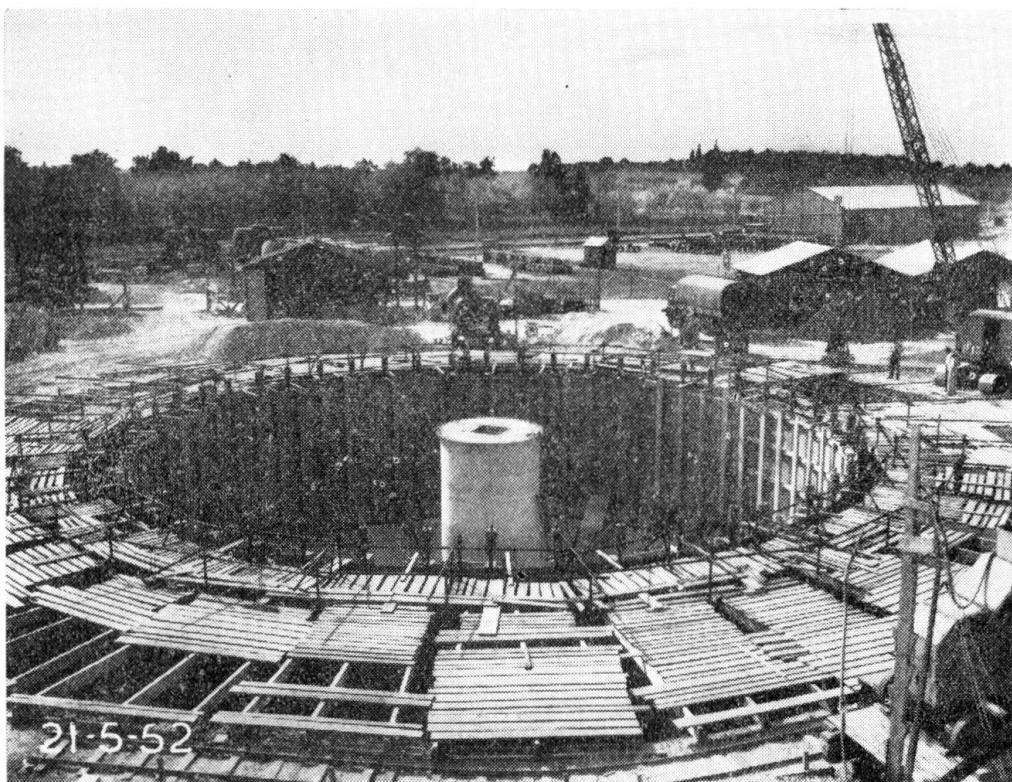
Réservoir à hydrocarbures de 2700 m<sup>3</sup>
