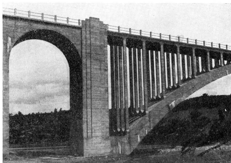
FIG. 16. Ponte em arco, betonado por anéis
