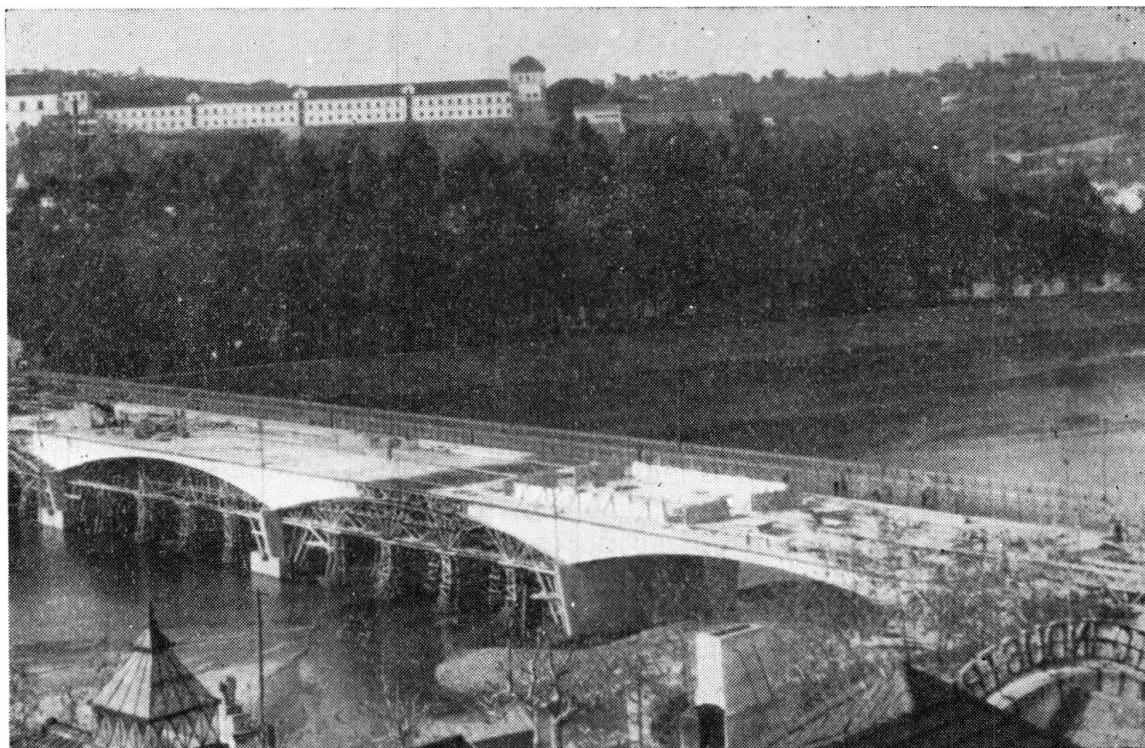
FIG. 9. Ponte de Coimbra — fase de construção — Superestrutura em funcionamento isostático por não estarem fechados os vãos 2.<sup>º</sup> e 4.<sup>º</sup>
