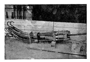
Fig. 6. Dispositif d'ancrage—Assemblages soudés  $\phi$ 32- $\phi$ 64
