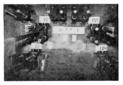
Fig. 8. Ancrages.—Voile 9 sur culée. Les numéros des câbles sont portés sur le voile, afin d'éviter les erreurs en cours d'exécution du programme de mise en tension
