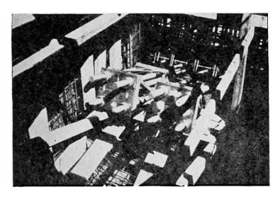
Fig. 7. Ancrages.—Mise en place dans le ferraillage d'un voile. On distingue les gabarits métalliques percés d'un trou central et permettant la mise en place correcte de l'ancrage par rapport à un fil métallique matérialisant l'axe du câble
