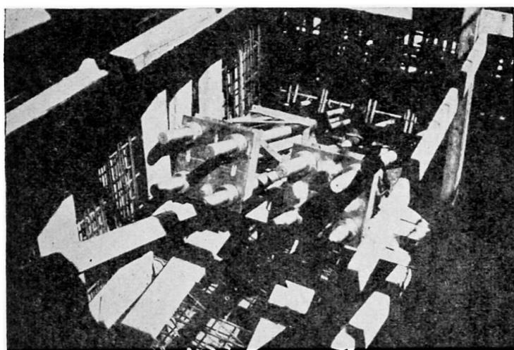
Fig. 7. Ancrages.—Mise en place dans le ferraillage d'un voile. On distingue les gabarits métalliques percés d'un trou central et permettant la mise en place correcte de l'ancrage par rapport à un fil métallique matérialisant l'axe du câble
