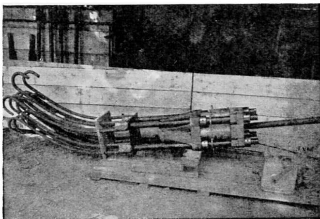
Fig. 6. Dispositif d'ancrage—Assemblages soudés  $\phi 32-\phi 64$
