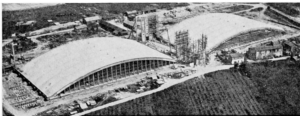
Fig. 27. Couverture prête au levage
