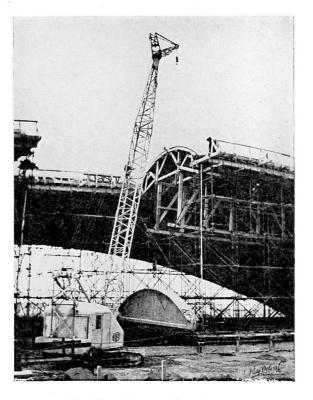
Fig. 25. Levage d'un tympan
