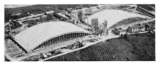
Fig. 27. Couverture prête au levage
