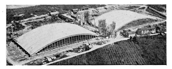
Fig. 27. Couverture prête au levage
