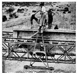
Fig. 9. Chariot de roulement
