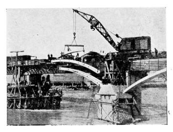
Fig. 13. Pose des arcs préfabriqués
