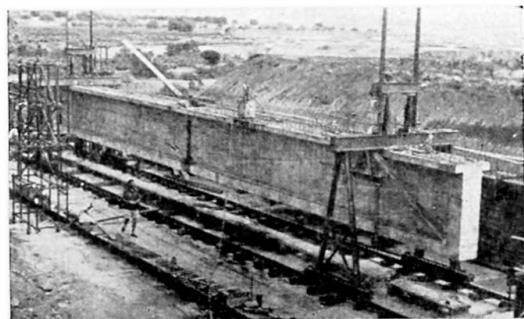
Fig. 8. Roulage d'une poutre sur la rive
