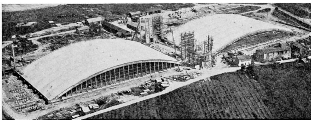
Fig. 27. Couverture prête au levage
