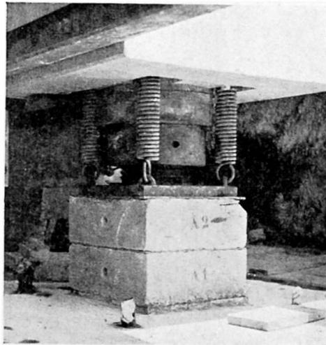
Fig. 28. Appui sur vérin
