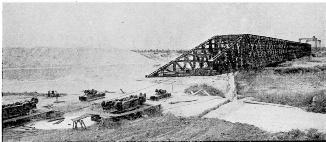
Fig. 10. Pont rail de Bollène—Ouvrage en cours de lançage
