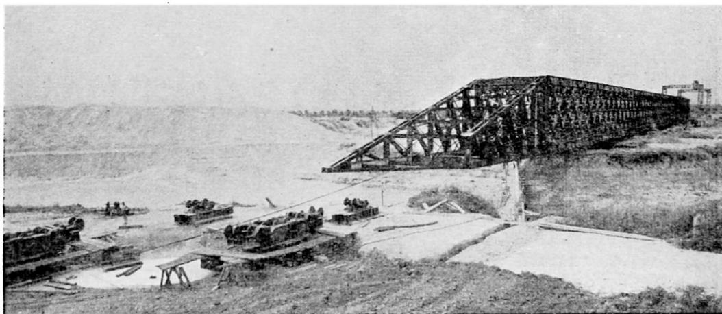
Fig. 10. Pont rail de Bollène—Ouvrage en cours de lancement
