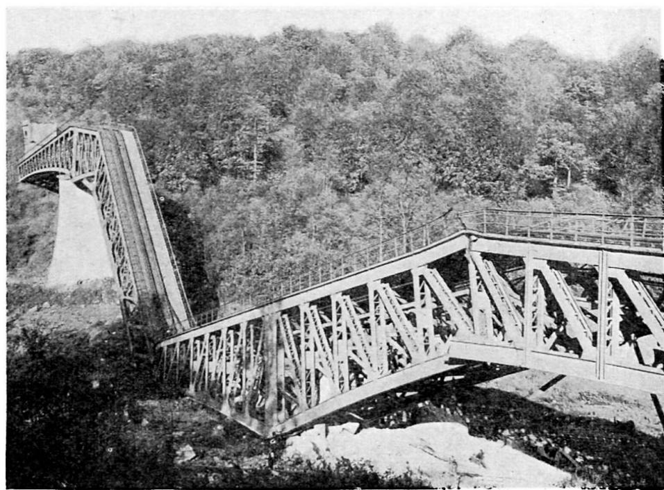
**Fig. 6.** Viaduc de Serrouville. Destruction—détail de la 1ère cassure côté Conflans
