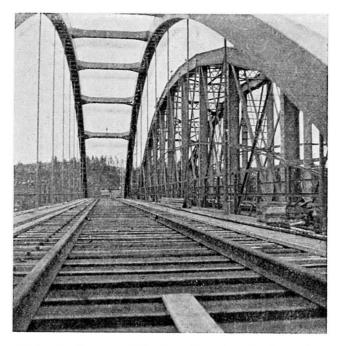
**Abb. 6.** Oberer Windverband zwischen den Bogen.
