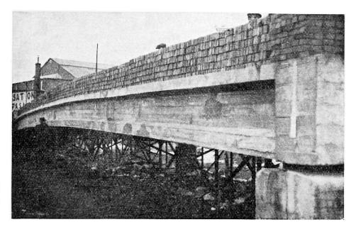
Fig. 4. Poutre expérimentale de 30 mètres de portée.
