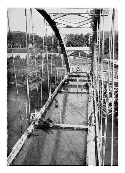
Fig. 9. Essais de réception par surcharge hydraulique.
