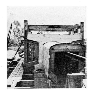
Fig. 9 à 12. Divers stades de bétonnage de la passerelle de Malheyde.
