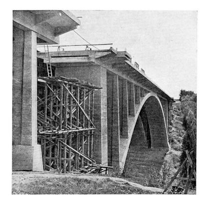
dissantes est de 1<sup>m</sup>75. La sollicitation des arcs est 60 %, celle des poutres raidissantes 40 %. La sécurité des arcs contre le flambement s'élève à 6,88. Les cadres continus constituent les viaducs; sur la rive gauche avec une longueur de 58<sup>m</sup>95 et sur la rive droite avec une longueur de 66<sup>m</sup>38. La hauteur de la chaussée sur le pont au-dessus de la vallée est de 46 mètres.
