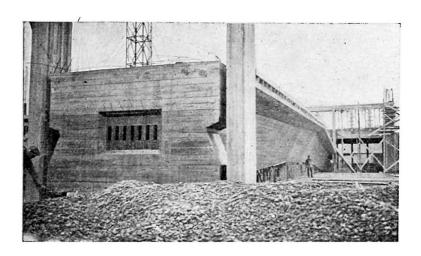
comme tensions de sécurité 140 kg/cm² pour le béton et 85 kg/mm² pour les fils.
