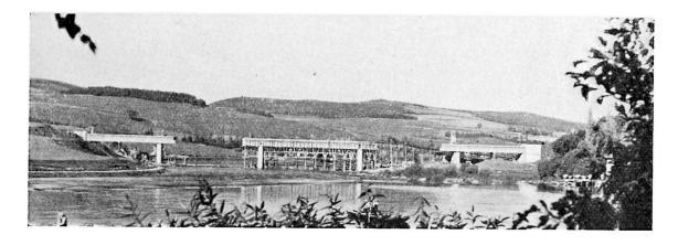
Le pont a 5 travées  $(34^m50 + 3 \times 50 \text{ m} + 34^m50)$ . La superstructure en béton armé est formée par quatre dalles continues de  $36^{m}85 + 3 \times 52^{m}50 + 36^{m}85$  de portée avec deux articulations dans la 2° et la 4° travée. Ce type de construction fut choisi parce qu'il s'incorporait le mieux dans une vallée plate.
