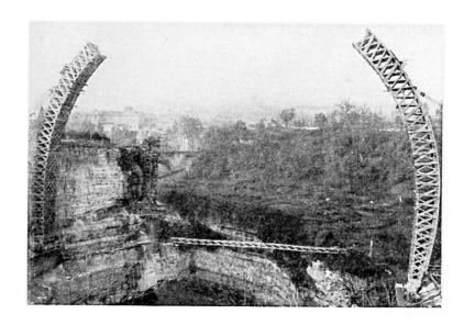
**Fig. 5.** Montage du cintre du pont de Savoie.
