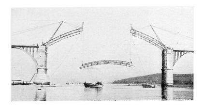
Fig. 8. Montage de l'ossature métallique de l'arc central.
