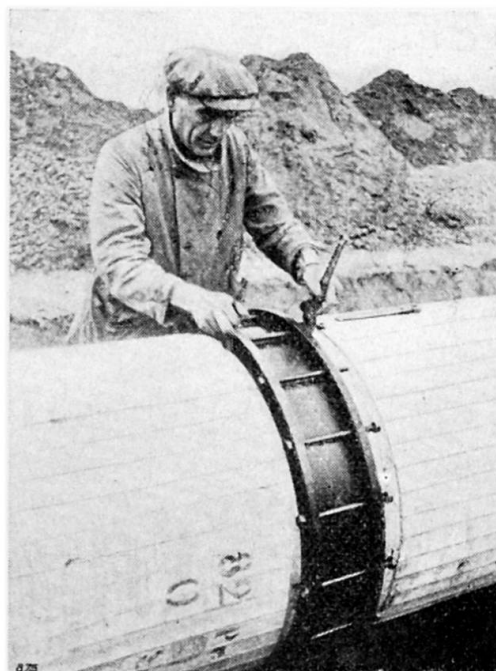
Fig. 9 et 10. Conduites forcées de l'Oued-Fodda : Parc de stockage et pose du joint.
