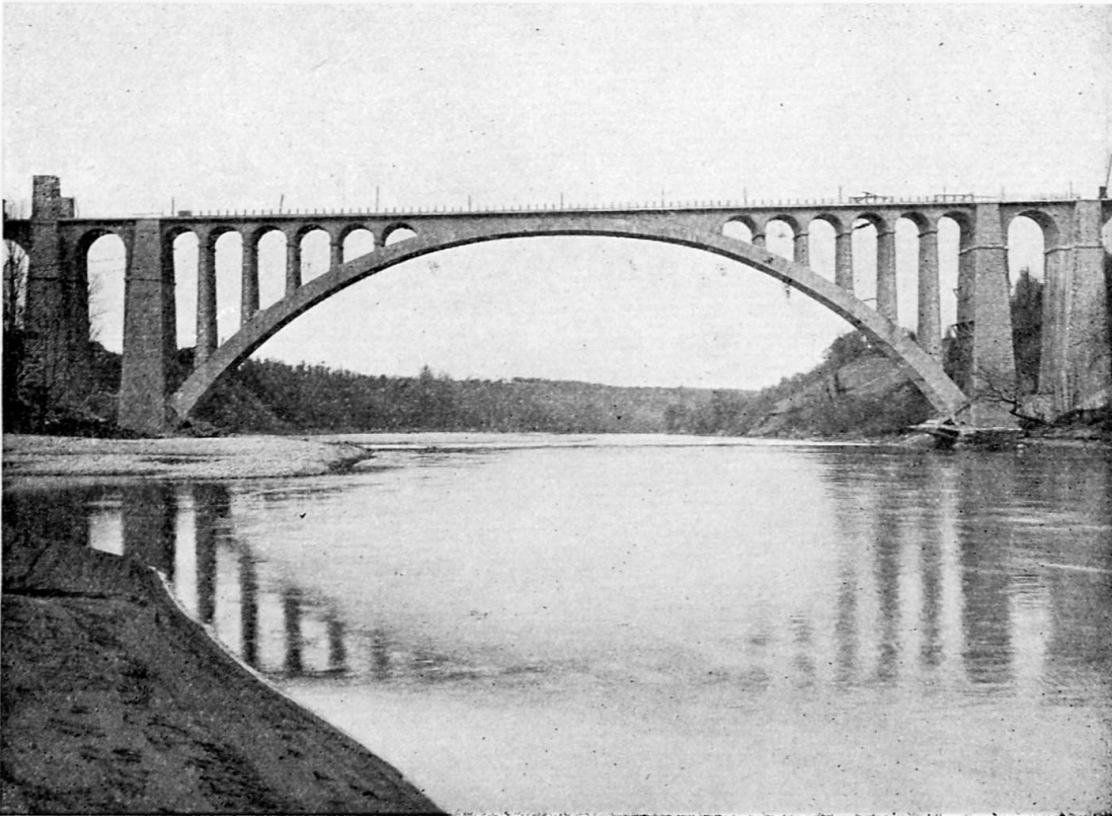
Fig. 1. Pont de Saint-Hilaire-Saint-Nazaire.
