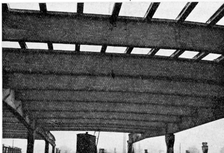
Fig. 2 à 4. Chantier pour la construction d'une importante usine textile à Gand.
