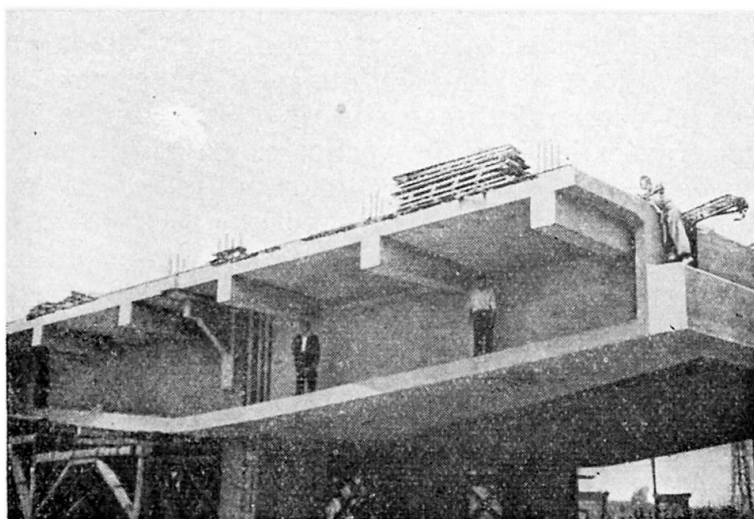
Fig. 13. Détail de l'appui de la partie centrale en cantilever.
