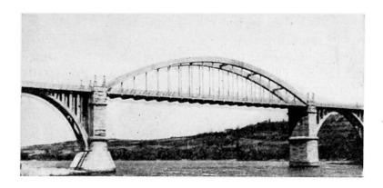
Fig. 2. Travée centrale de 75 mètres d'ouverture.
