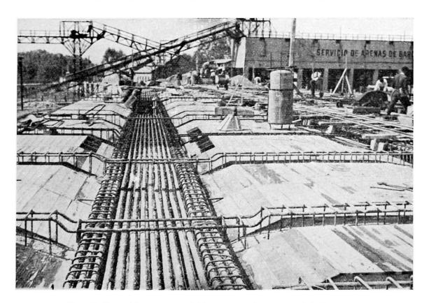
Fig. 14. Ferraillage assemblé par soudure avant bétonnage.
