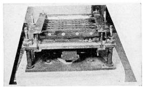
Fig. 4. Moule pour éprouvettes type nº 1, avec son couvercle, monté sur la table vibrante.
