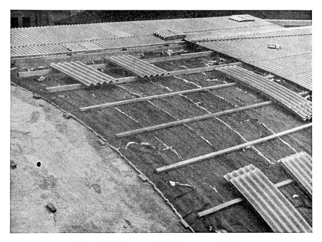
Abb. 3. Isolation und Eindeckung der Schalen.
