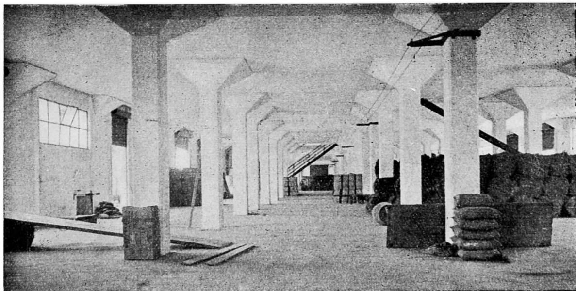
**Fig. 5.** Magasin à marchandises au port de Pasajes (San Sebastian) prévu pour des surcharges de 1500 à 2500 kg/m<sup>2</sup> et d'une superficie bâtie de 126 × 24 m.
