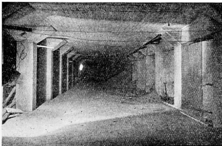
**Fig. 3.** Sous-sol du bâtiment central de l'Institut National de Prévision (Madrid) d'une surface utile de 3 600 m<sup>2</sup>. La surcharge utile est de 900 kg/m<sup>2</sup>.
