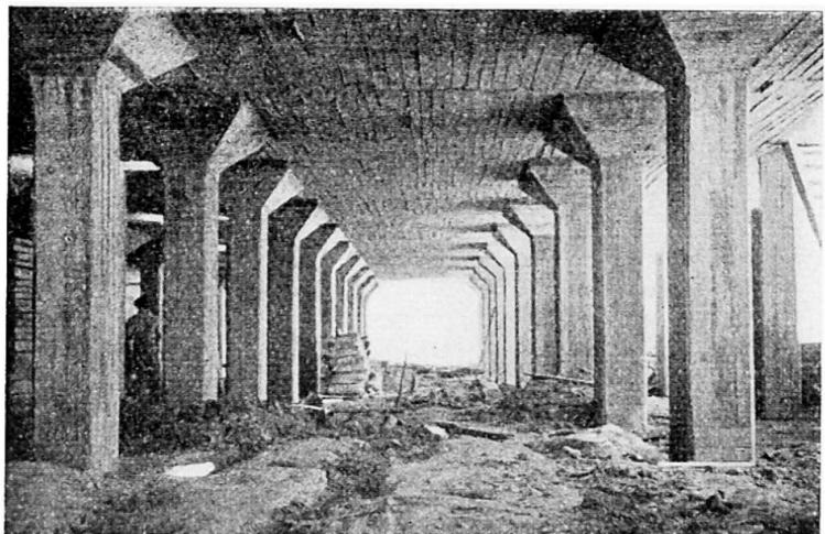
**Fig. 7.** Sous-sol de l'Hôtel des Monnaies (Madrid) supportant des presses. Superficie : 1 200 m<sup>2</sup>. Surcharge : 1 000 kg/m<sup>2</sup>.
