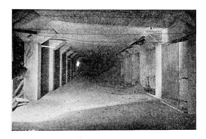
Fig. 3. Sous-sol du bâtiment central de l'Institut National de Prévision (Madrid) d'une surface utile de 3 600 m². La surcharge utile est de 900 kg/m².
