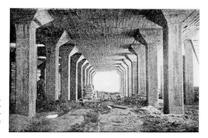
**Fig. 7.** Sous-sol de l'Hôtel des Monnaies (Madrid) supportant des presses. Superficie: 1 200 m<sup>2</sup>. Surcharge: 1 000 kg/m<sup>2</sup>.
