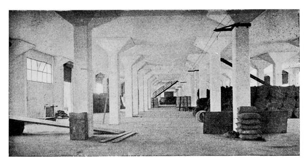
Fig. 5. Magasin à marchandises au port de Pasajes (San Sebastian) prévu pour des surcharges de 1500 à 2500 kg/m<sup>2</sup> et d'une superficie bâtie de  $126 \times 24$  m.
