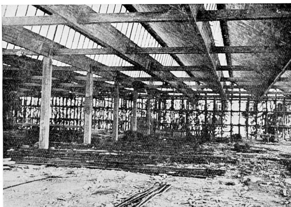
Fig. 4. Vue à l'intérieur après décoffrage.
