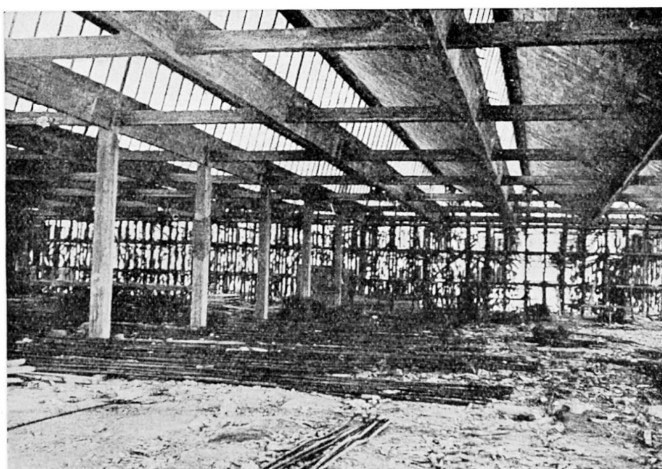
Fig. 4. Vue à l'intérieur après décoffrage.
