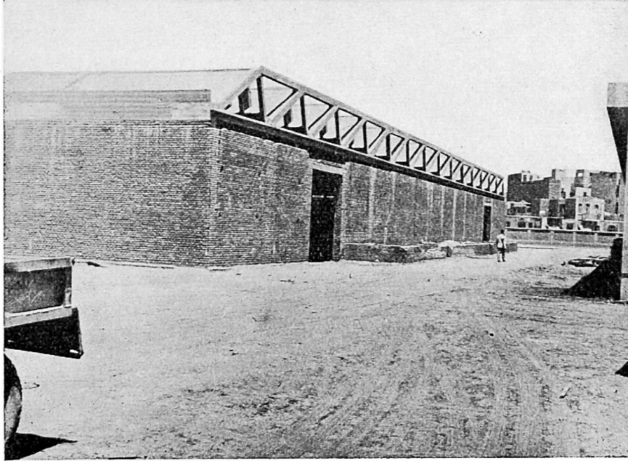
Fig. 7. Vue de la poutre continue sur façade.
