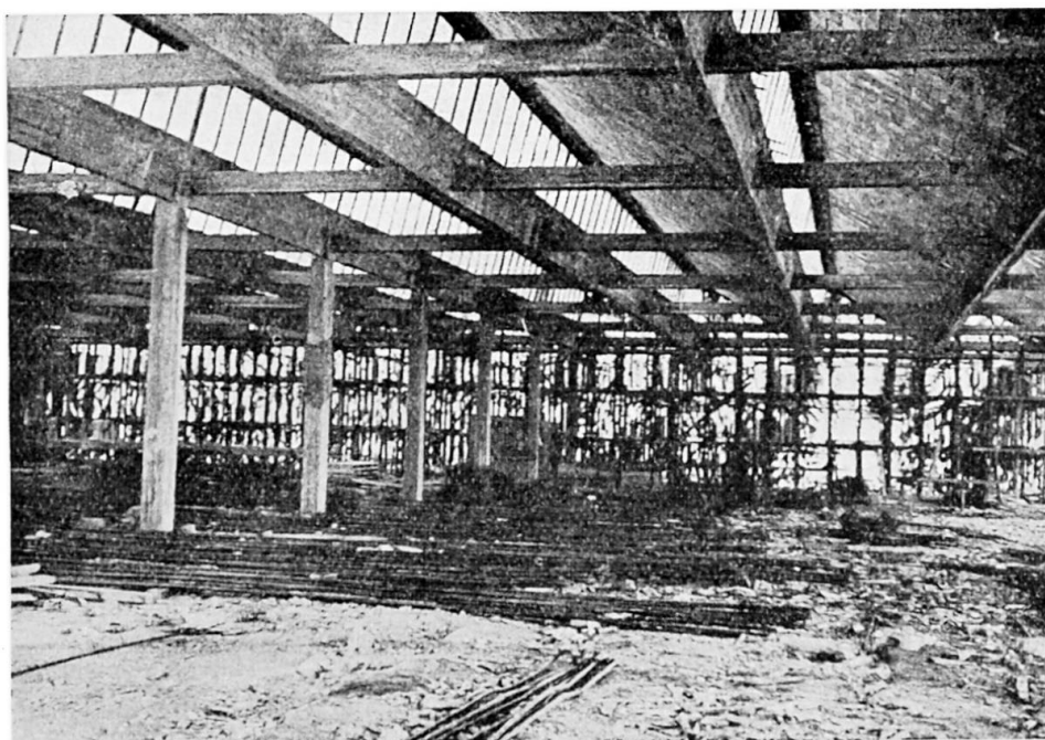
Fig. 4. Vue à l'intérieur après décoffrage.
