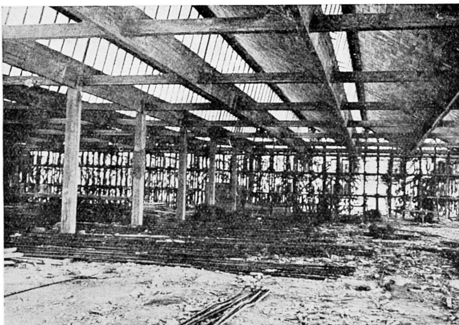
Fig. 4. Vue à l'intérieur après décoffrage.
