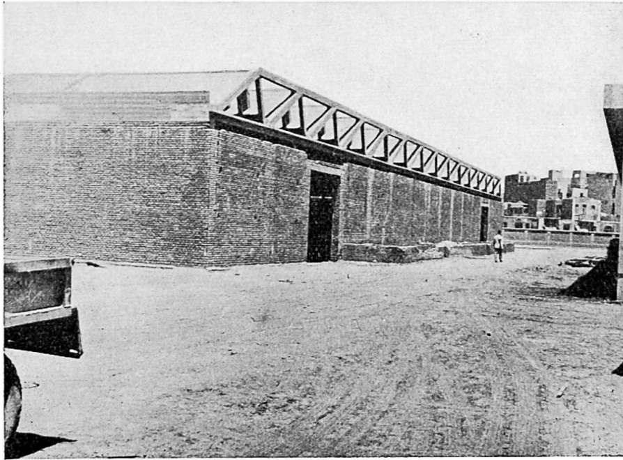
Fig. 7. Vue de la poutre continue sur façade.
