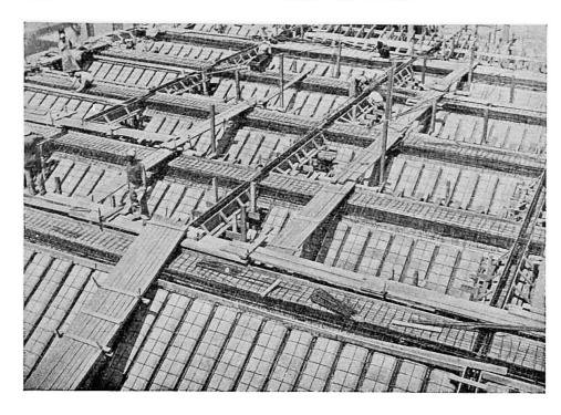
Fig. 5. Vue de la pose des hourdis cellulaires.
