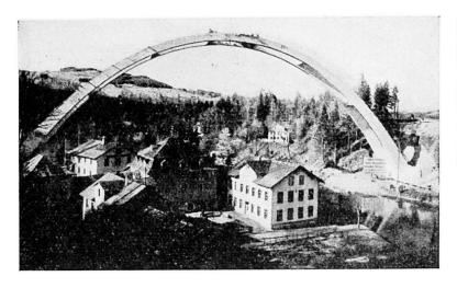
Abb. 10 und 11. Probebelastung des freien Bogens mit Kiesbelastungen in hölzernen Behältern.
