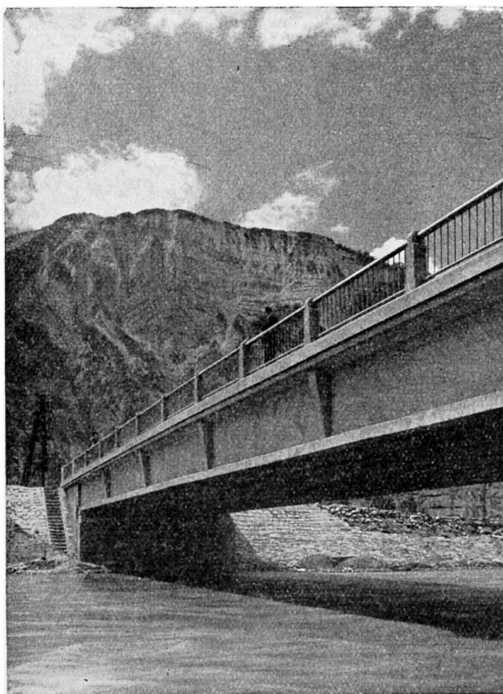
Fig. 15. Pont de Bourg-d'Oisans (Isère).
