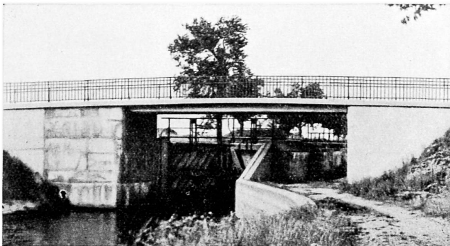
Fig. 10. Pont sur l'écluse n° 4 (Territoire de Belfort).
