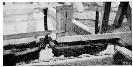
Fig. 15 et 16. Détails du dispositif de mesure de l'expansion utilisé pour le viaduc de Laroche.
