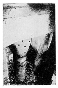
Fig. 9 à 11. Armatures, bétonnage et têtes de pieux achevées pour le Palais Rihour, à Lille.
