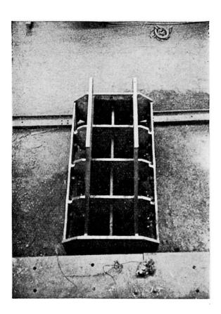
une liberté complète des pièces et étaient génératrices de tensions résiduelles, dont l'existence n'était pas souhaitable en raison du rôle primordial joué par les sabots d'ancrage dans le fonctionnement de l'ouvrage.
