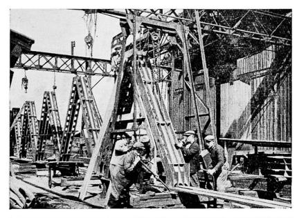
Fig. 5. Assemblage d'une poutre à l'atelier.
