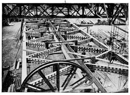
Fig. 7. Essai en atelier. Vue d'ensemble des vérins agissant sur les nœuds.
