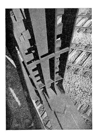
Fig. 11. Assemblage d'une diagonale avec la membrure inférieure.
