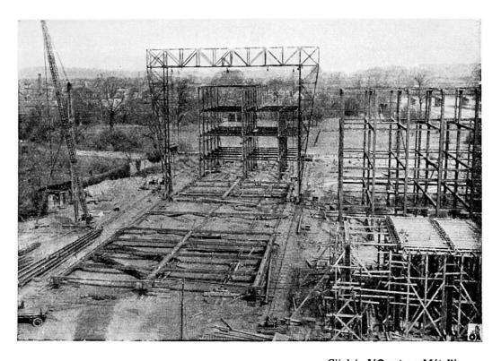
Clichés L'Ossature Métallique. Fig. 1. Charpente métallique des blocs des laboratoires; l'assemblage des formes par soudure au sol est à noter, le relevage se faisant au moyen du portique visible au centre de la figure.
