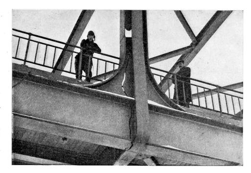
Fig. 2. Rupture dans une poutre, composée par soudure, constituant membrure inférieure, à la jonction avec une entretoise et avec un montant.
