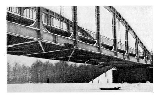
Fig. 1. Rupture dans un profilé constituant membrure in férieure, à la jonction avec une entretoise et avec un montant.
