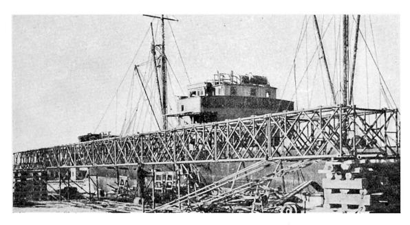
Abb. 23. Versuchsmontage einer Brücke von 36 m Spannweite.
