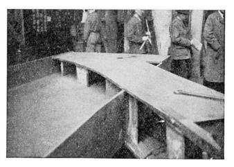
**Abb. 8.** Anschluss des Bogens an den Versteifungsträger.
