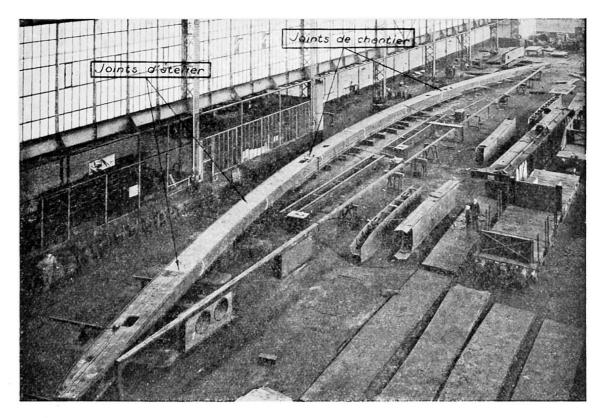
Fig. 7. Construction en atelier d'un arc de 67 mètres du pont de Neuilly.
