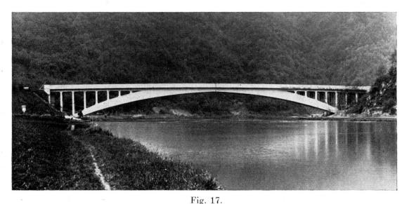
Dreigelenkbogenbrücke von 97,00 m Stützweite über die Maas in Laifour.
