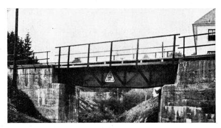
Fig. 1. Elektrisch geschweißte Eisenbahnbrücke bei Weiz.
