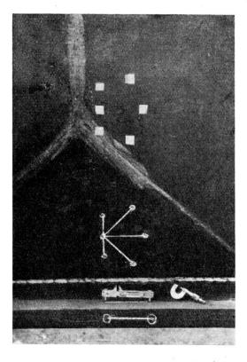
Fig. 7. Stehblechstoß Seetalbahn S.B.B.
