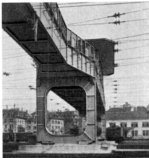
Fig. 13. Befehlsstellwerkbrücke HB. Zürich.
