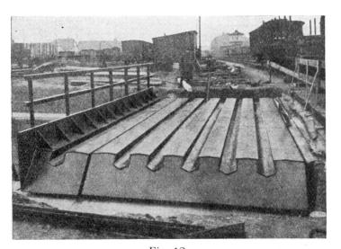
Fig. 12. Tablier du système Schröder.
