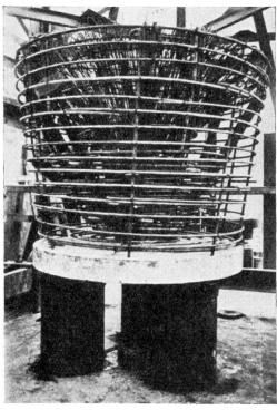
Fig. 6. Ferraillage d'une tête.
