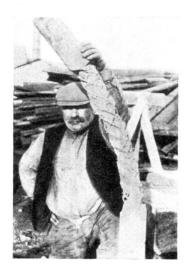
Fig. 8. Tirant avec frettage spécial.
