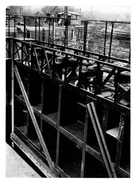
Fig. 10. Vantail amont de l'écluse de Wyneghem.
