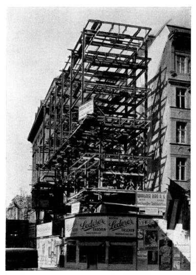
${\rm Fig.~5.}$  Ossature métallique à Lichtensteg à Vienne.
