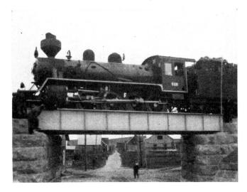
Fig. 5.Pont-rails de 12 m de portée.
