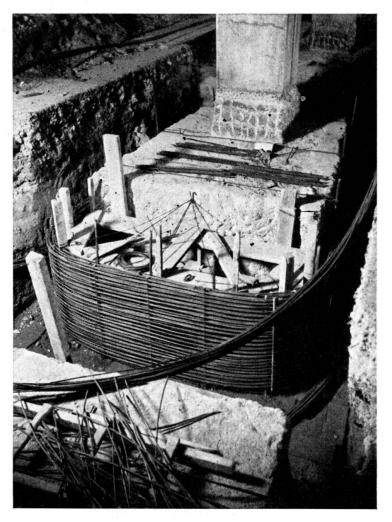
Fig. 10.Ferraillage d'une tête de tirant.
