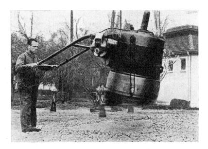
Fig. 13. 1000 kg Delmag Frosch im Sprung.
