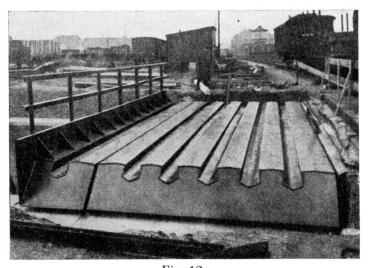
Fig. 12. Die eingebaute Fahrbahntafel — Bauart Schröder.
