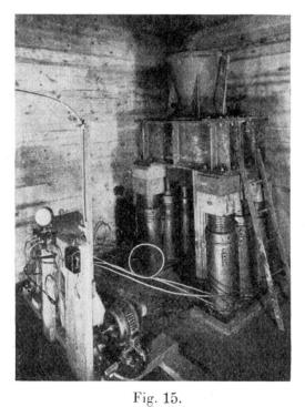
Marèges-Staumauer. Verankerung des Gewichtswiderlagers. Anziehen eines Zugankers mit Hilfe von 6 hydraulischen Pressen.
