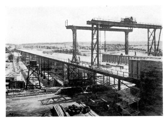
Fig. 2. Montage der Stahlbalkenbrücken auf massiven Pfeilern bei Rüdersdorf. Autobahn Berliner Ring. \* Stützweiten:  $44.0+5\times61.2+2\times42.0+4\times61.2+47.0$ . Höhe 19 m.
