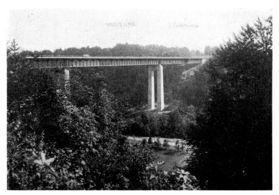
Fig.~6. Mangfallbrücke. Reichsautobahn München—Landesgrenze (Salzburg). Stützweiten: 90+108.0+90. Höhe über Flußsohle 68 m.
