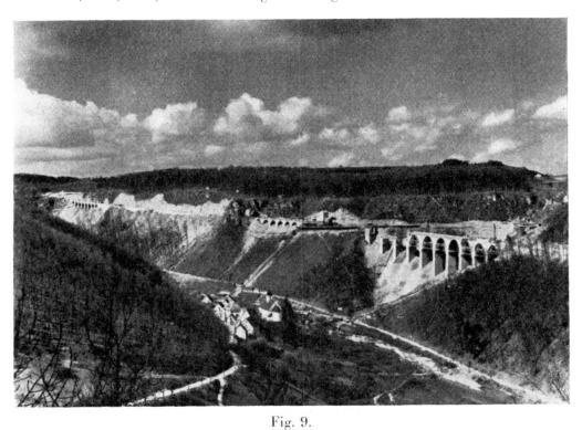
Drachenlochbrücke im Zuge der Reichsautobahn Stuttgart—Ulm. Abstieg von der Schwäbischen Alp. Eisenbeton. Stützweiten  $9\times15,5$ . Höhe über Gelände  $42\,\mathrm{m}$ .
