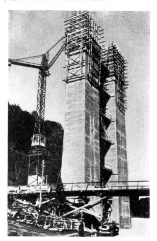
Fig. 7. Pfeiler der Mangfallbrücke. Wandungen aus Eisenbeton.
