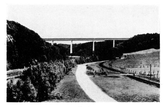
Fig. 4. Talbrücke bei Siebenlehen. Reichsautobahn Dresden—Chemnitz. 6 Felder. Stützweiten: 56.1+61.2+71.4+81.6+71.4+61.2. Höhe 70 m.
