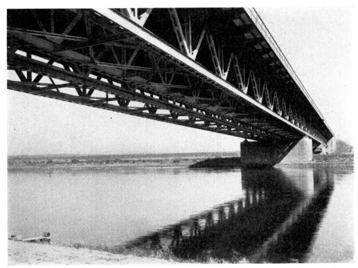
Fig. 3. Elbebrücke bei Dresden. Reichsautobahn Chemnitz—Dresden—Breslau. 5 Öffnungen. Stützweiten: 51.0+73.0+130.0+73.0+51.0.
