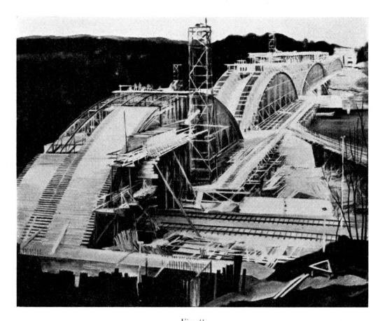
$\label{eq:Fig. 8.} Fig. 8.$  Donaubrücke bei Leipheim. Reichsautobahn Stuttgart—München. 4 Eisenbeton-Dreigelenkbögen. Stützweiten: 71+81+81+71. Darstellung des Lehrgerüstes nach einem Gemälde von Protzen.
