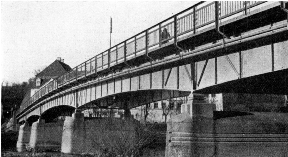
Fig. 6. Straßenbrücke über die Donau bei Donauwörth (größte Stützweite 32 m, 1876).
