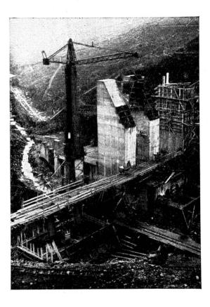
Fig. 10. Zillierbachsperre, Ansetzen der Stahlschalung.
