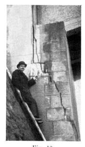
Fig. 12. Fissure dans l'une des culées du pont sur le Sajó à Sajólád.
